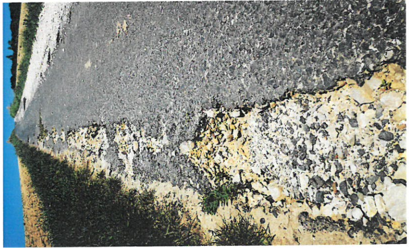
Kallósd 030.hrsz út csapadékvíz okozta kár
